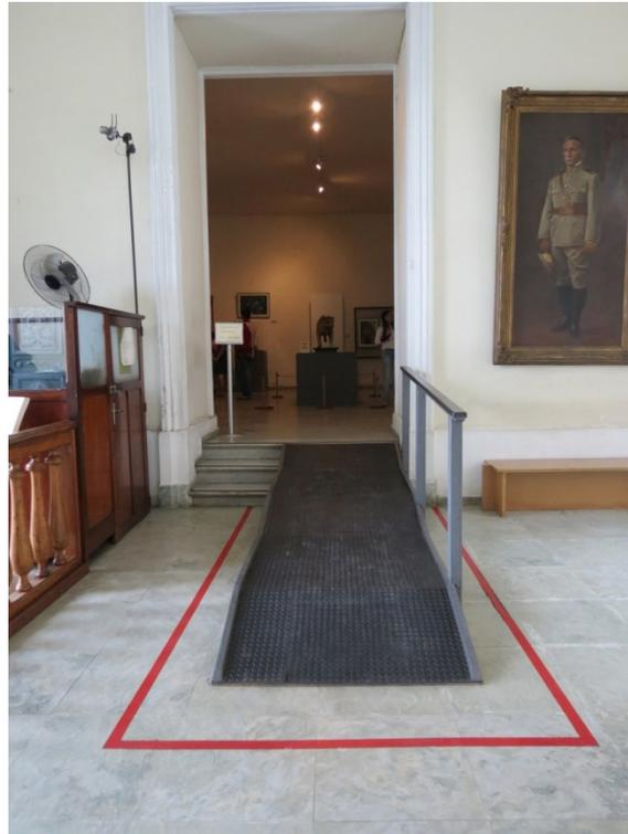
Figura 23 - Acesso à exposição A (R)evolução das plantas através de rampa fora do padrão ABNT
