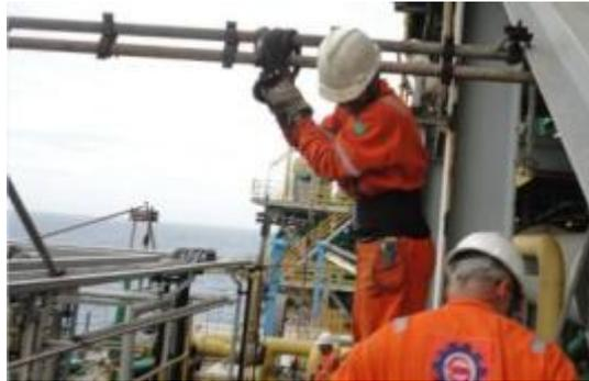
Figura 76 – Auxiliar prende cinta no andaime para montagem da talha
