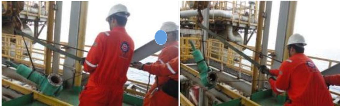
Figura 80 – Equipe segura a talha com cintas e cabo-guia para evitar pancadas nas estruturas
