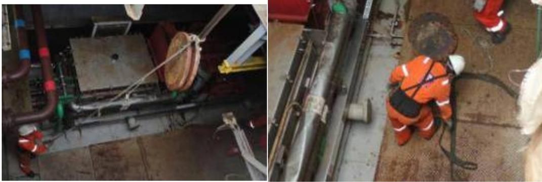
Figura 74 – Auxiliares no Paiol de Ré manipulam o flange com cabo-guia e estacionam no piso
