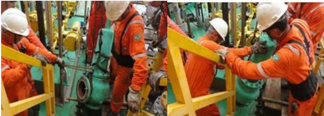
Figura 79– Supervisor e auxiliar passam a PSV por cima do andaime com o auxílio de cabo-guia
