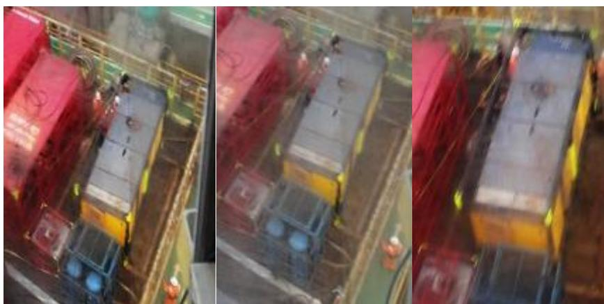
Figura 44 – Equipe auxilia o guindasteiro no posicionamento do compressor.
