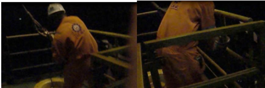
Figura 18 – Auxiliar recebe a eslinga do guindaste e prende no bordo da plataforma
