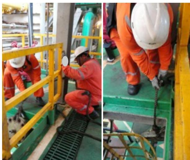
Figura 48 – Supervisor vai liberando o cabo-guia e auxiliar direciona o flange
