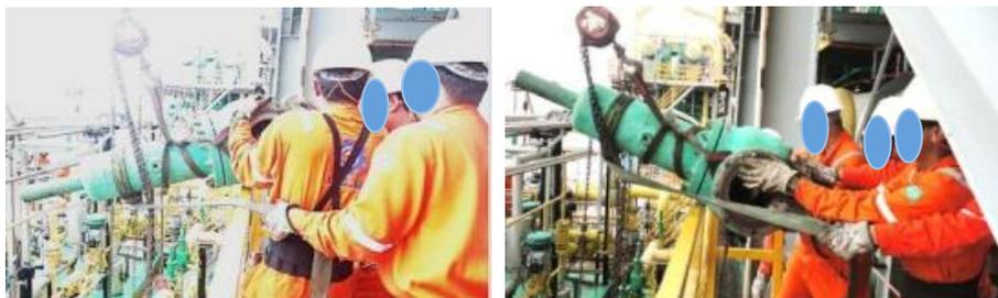
Figura 11 – Equipe tem dificuldade para passar com a PSV sobre o guarda-corpo
