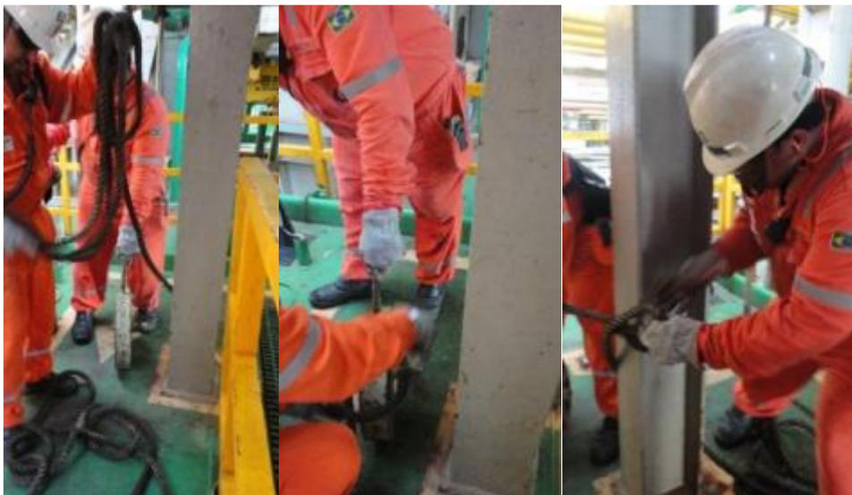
Figura 47 – Auxiliar e supervisor recebem o cabo-guia, amarram no flange e enroscam em uma viga
