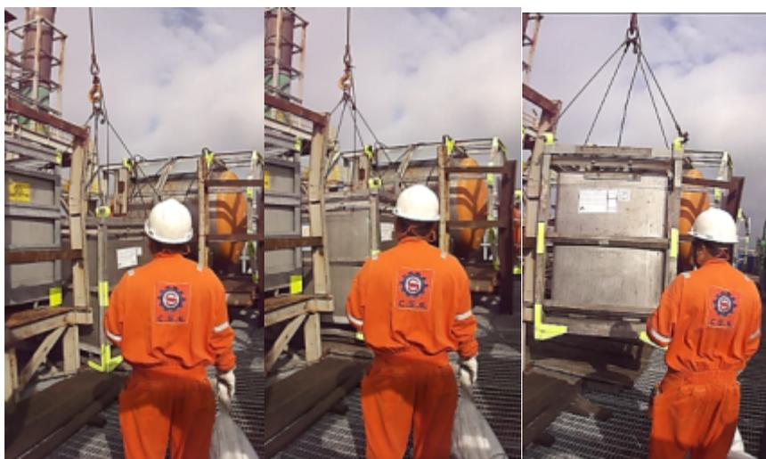
Figura 32 – Guindasteiro retira lateralmente a carga antes de elevar e auxiliar observa
