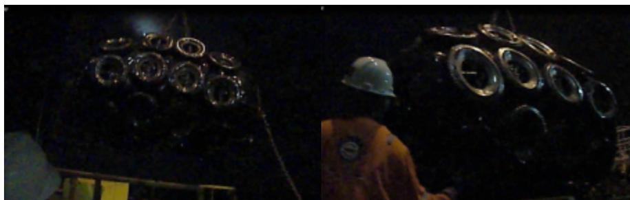
Figura 19 – Guindasteiro eleva defesa e posiciona no berço enquanto auxiliar dá assistência
