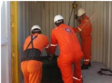
Figura 91 – Equipe utiliza talha para auxiliar no posicionamento da válvula
