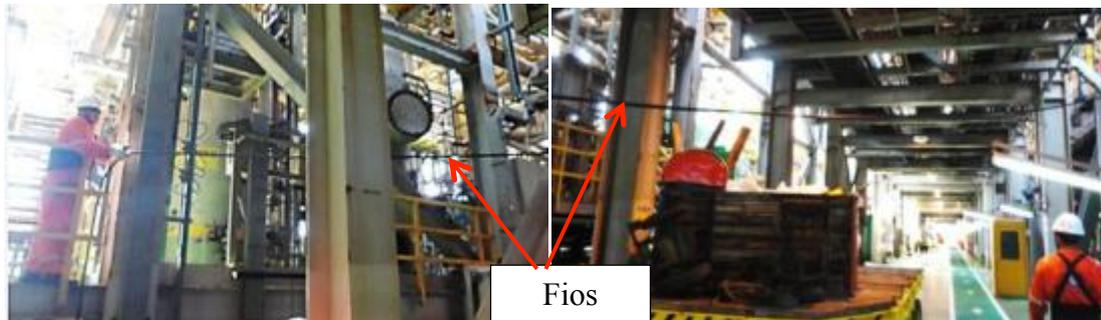
Figura 57 – Auxiliar sobe em escada do módulo para elevar fio
