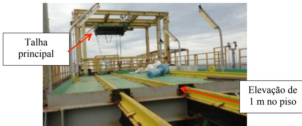
Figura 75 – Para chegar até a talha seria preciso elevar a PSV a uma altura de 1 metro
