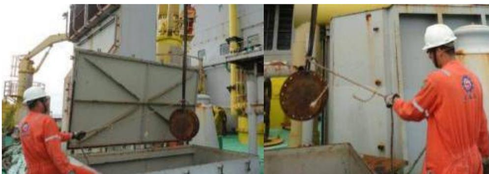
Figura 73 – Supervisor movimentava flange com triplex e auxiliar manipula com cabo-guia
