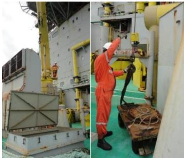
Figura 72 – Supervisor abre a tampa de proteção e auxiliares engatam cabo na cinta do flange
