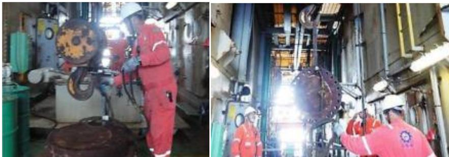
Figura 99 – Auxiliares prendem cinta da flange na talha e supervisor inicia a elevação
