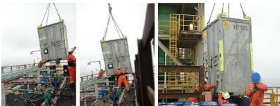
Figura 37 – Equipe manipula refil com as mãos e cabo-guia, e guindasteiro desce carga sobre tambores
