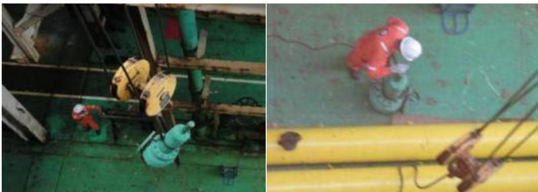
Figura 81 – Supervisor desce a PSV com a talha e auxiliar recebe no primeiro piso
