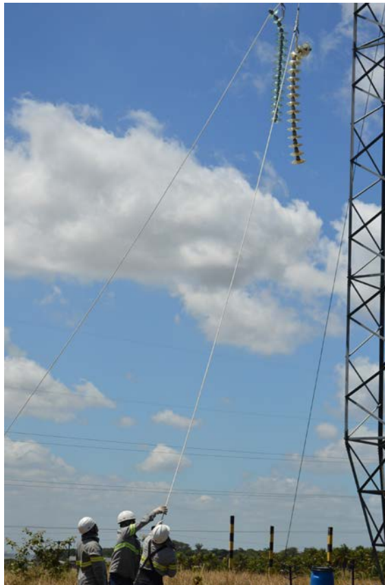
Figura 7-15 - Içamento da cadeia de isoladores nova por contrapeso
