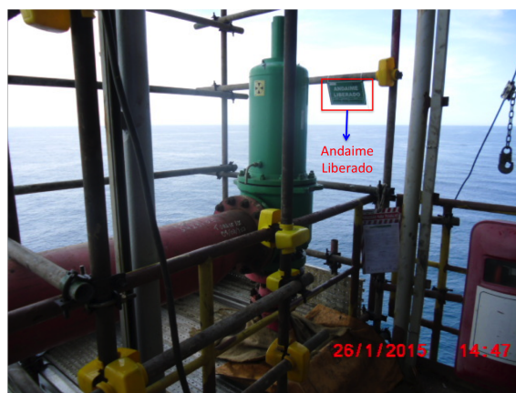
Figura 5.9: Local de intervenção do PSV, com andaime liberado e sob o mar. Fonte: fotografia realizada em campo pela autora.
