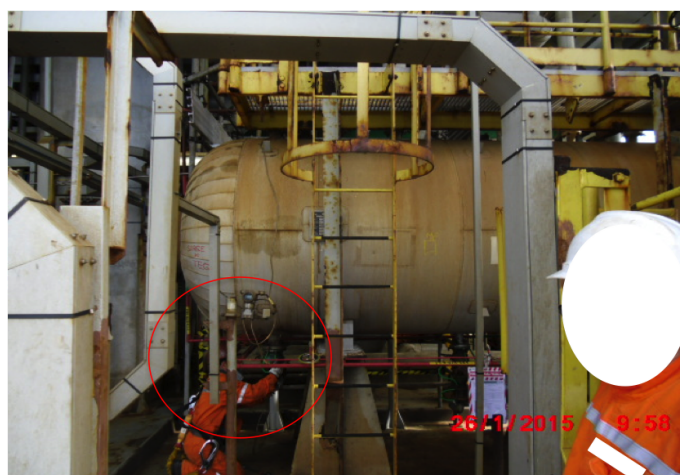
Figura 5.12: Região da válvula para a drenagem do vaso Fonte: fotografia realizada em campo pela autora.
