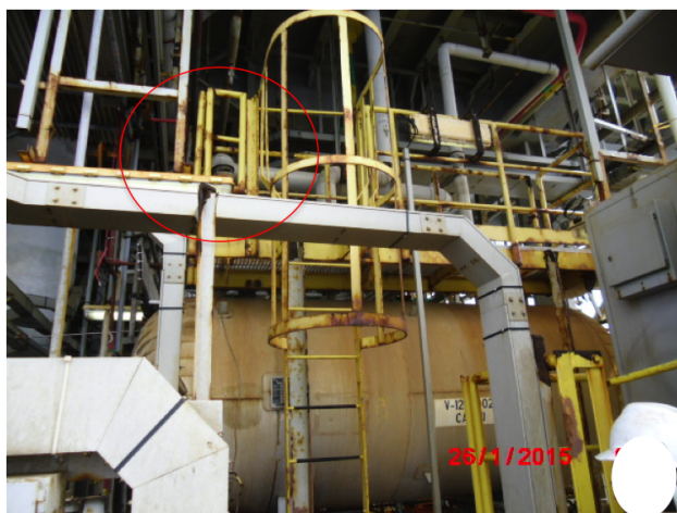
Figura 5.12: Região da válvula para a drenagem do vaso Fonte: fotografia realizada em campo pela autora.
