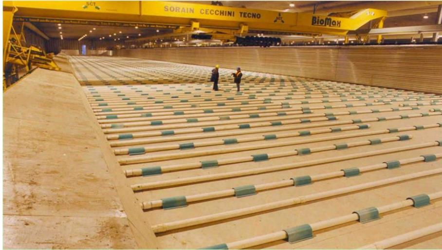
**FIGURA 9 - PLANTA TIPO BACIA COM AERAÇÃO FORÇADA POR TUBULAÇÃO (ESPANHA). FONTE: DIAZ (2011)**
