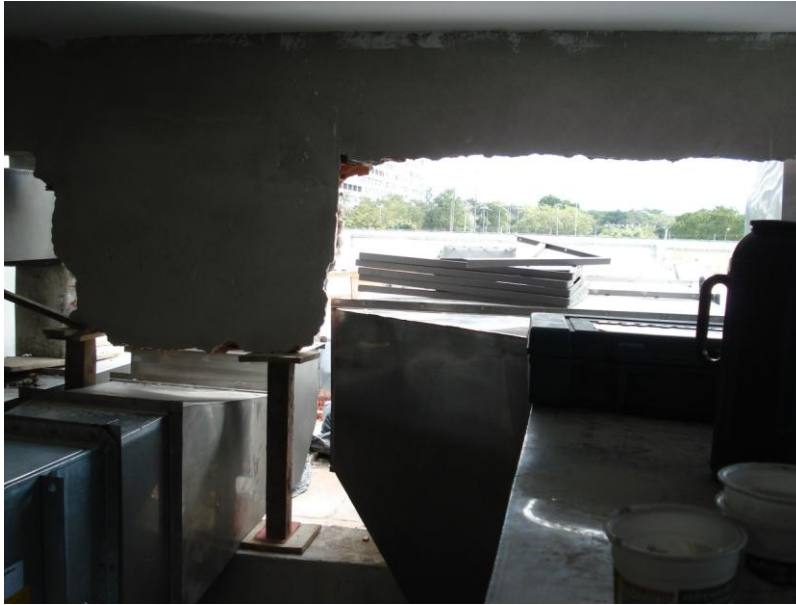
Foto 01 - Abertura em alvenaria para passagem de dutos.
