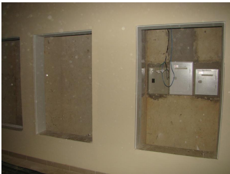
Foto 04 - Acesso às passagens entre pavimentos – shafts .
