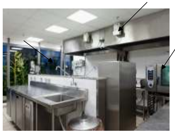
Figura 75: Cozinha 28º andar
