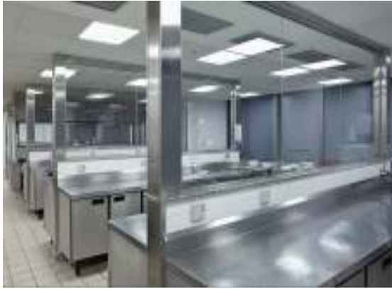
Figura 74: Cozinha 1º pavimento
