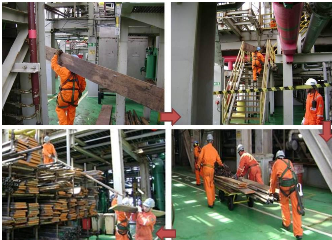
Figura 28 – Carregamento dos materiais utilizados para montagem do andaime utilizado para pintura do guindaste
