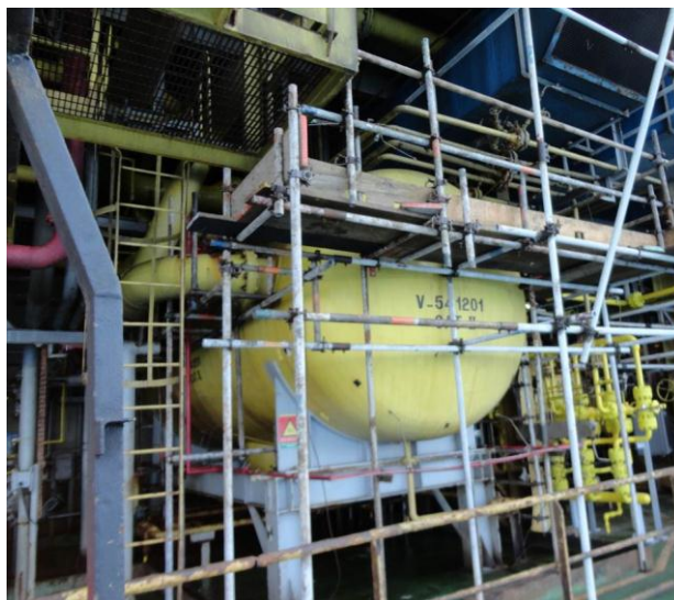
Figura 22 – Andaimos para conserto de tubings em P-B
