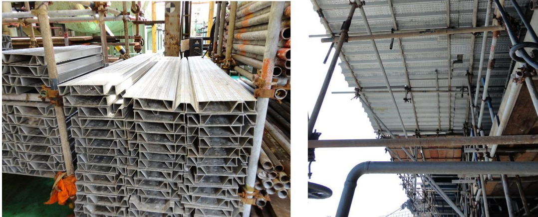
Figura 29 – Andaimos de alumínio utilizados como suporte às atividades de pintura
