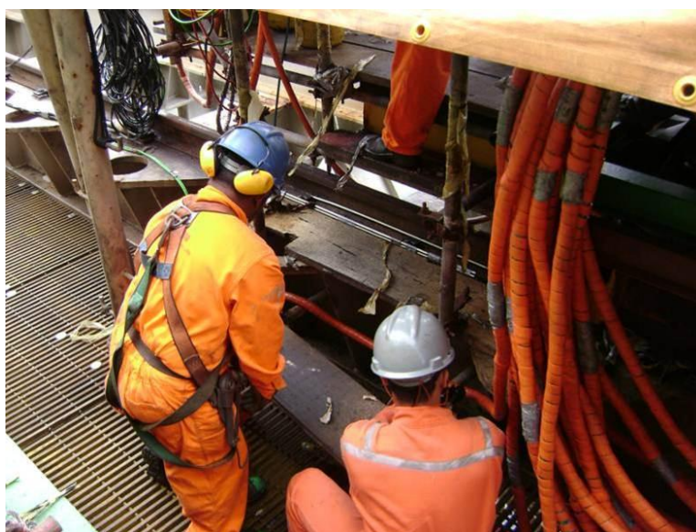
Figura 24 – Desmontagem do andaime de acesso ao pórtico de mergulho, em A
