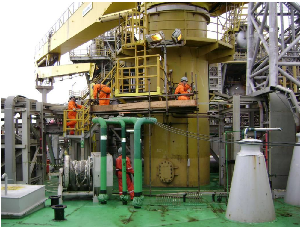
Figura 27 – Desmontagem de andaime utilizado para pintura em P-A
