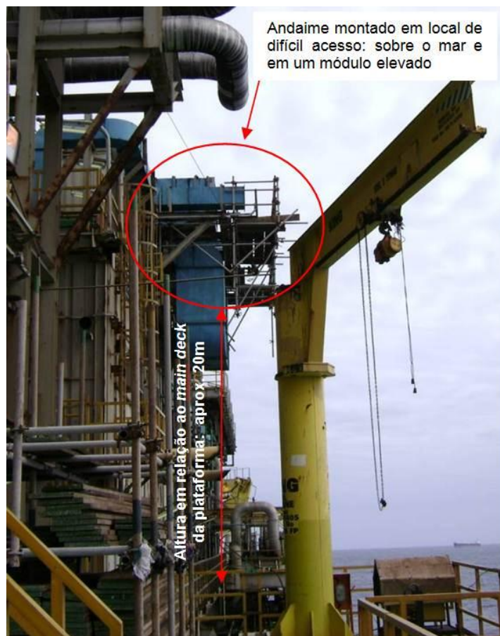
Figura 16 – Andaime para manutenção preventiva em sensor de gás, em P-A
