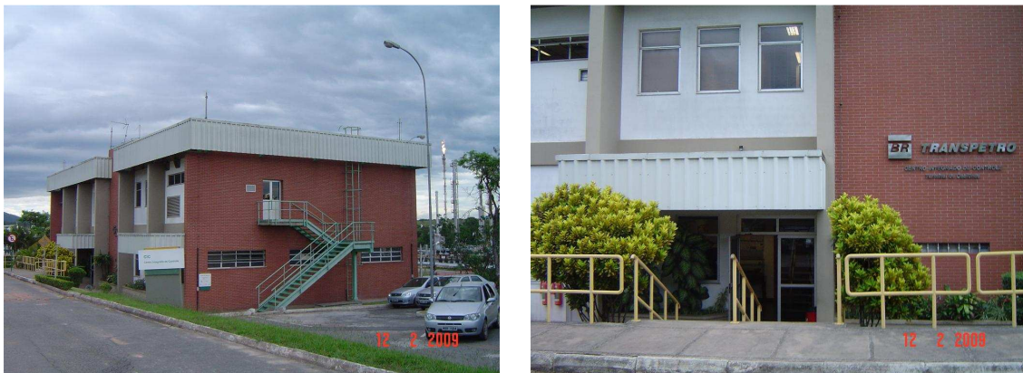
Figura 8 – Edifício do Centro Integrado de Controle, com detalhe do acesso principal
