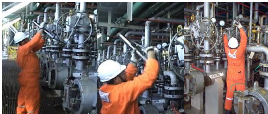
Figura 41 – utilização da bomba de inserção de graxa selante na manutenção filmada
