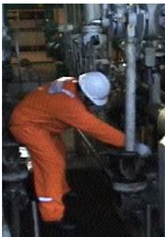
Figura 42 - amaciamento na válvula do dreno
