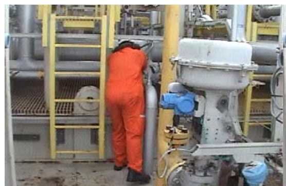
Figura 38 - atuação na válvula de liberação de diesel para o lançador
