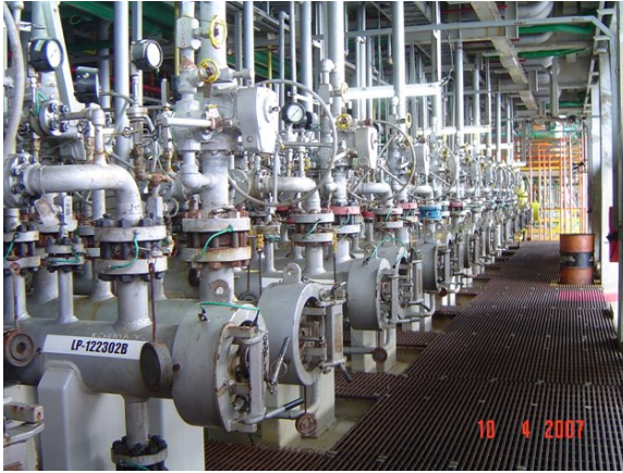
Figura 9 – Lançadores e recebedores de PIG
