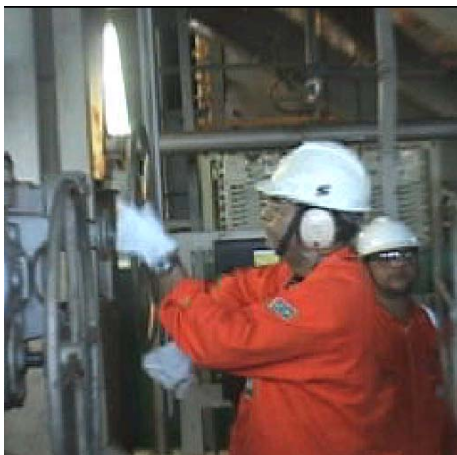
Figura 27 – manuseio de válvula no recebedor
