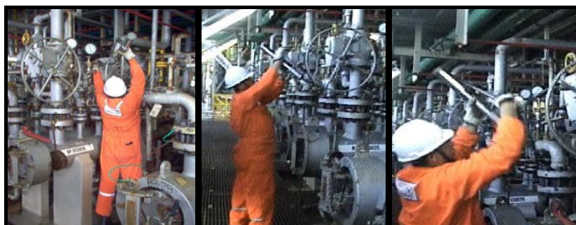
Figura 51 - Inserção de graxa selante com a bomba de alta pressão
