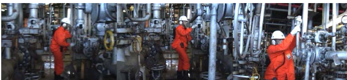
Figura 28 – alinhamento do lançador
