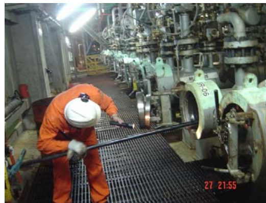
Figura 49 - Operador posicionando PIG para lançamento
