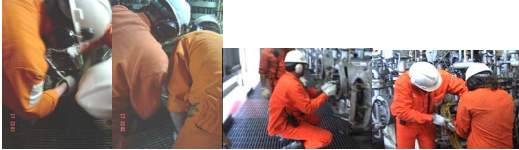
Figura 25 – fechamento do tampão da câmara de lançamento
