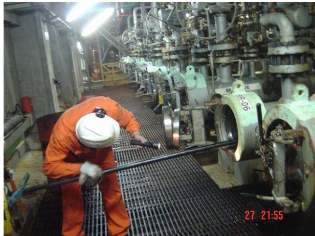
Figura 21 – inserção do PIG no lançador
