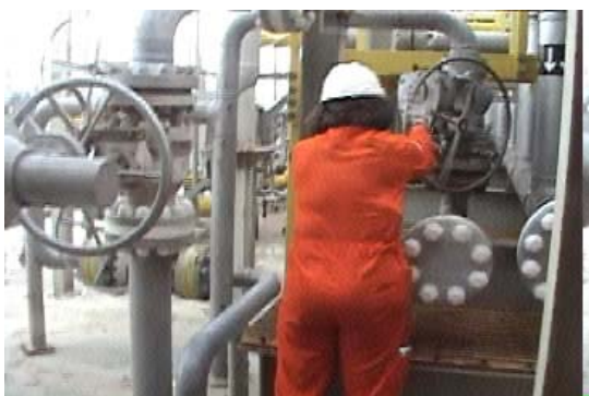
Figura 37 - atuação na válvula de liberação de diesel para o header
