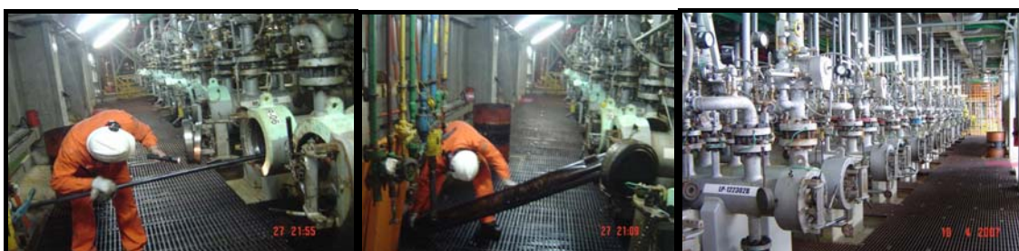
Figura 52 – utilização de bastão para colocação do PIG e inserção de cesta de recebimento
