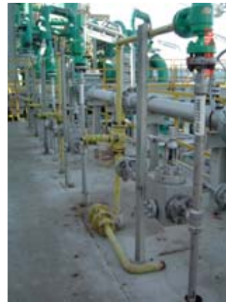
Figura 36 – área das PSVs no módulo 2A: sem obstruções nos acessos
