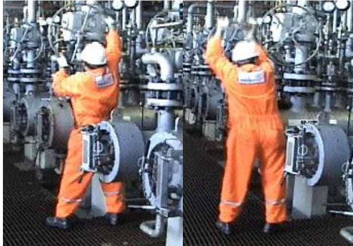
Figura 40 - amaciamento das válvulas na atividade filmada
