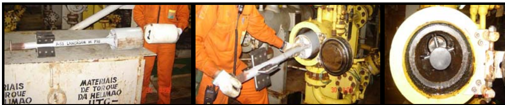
Figura 54 - aparato utilizado para o lançamento de PIG na P-50
