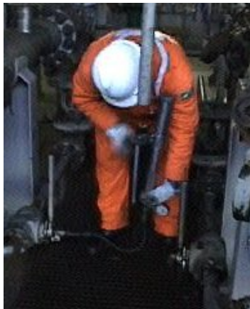
Figura 45 – inserção de graxa selante na válvula do dreno.
