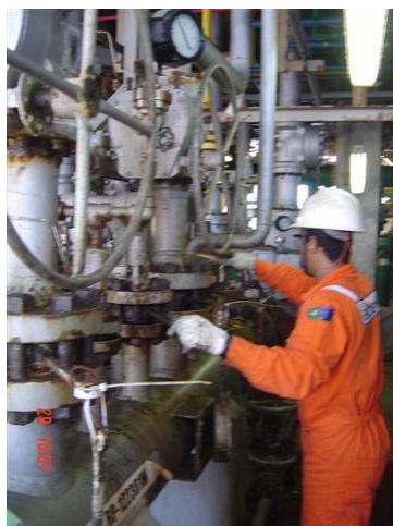
Figura 44 – lubrificação e limpeza dos estojos
