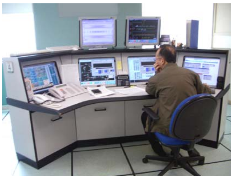
Figura B8 – Foto da sala de controle do óleo em 19 de abril de 2006
